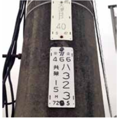
電柱に表示されている番号
