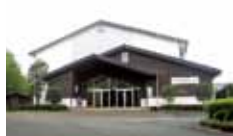
②旧迫水小体育館
