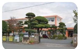
▲校舎の増床工事が行われている菊之池小学校
