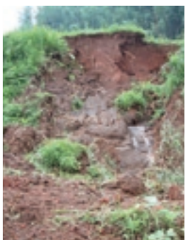
平成21年に起きた崖崩れ
