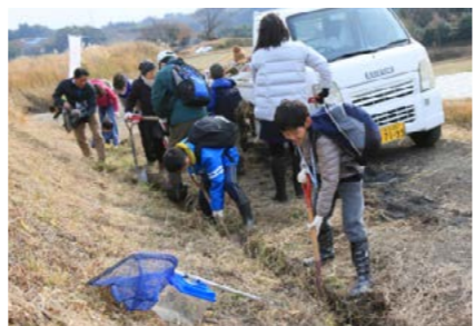
側溝に詰まった土砂をスコップで掘り出し水が流れるようにしました
