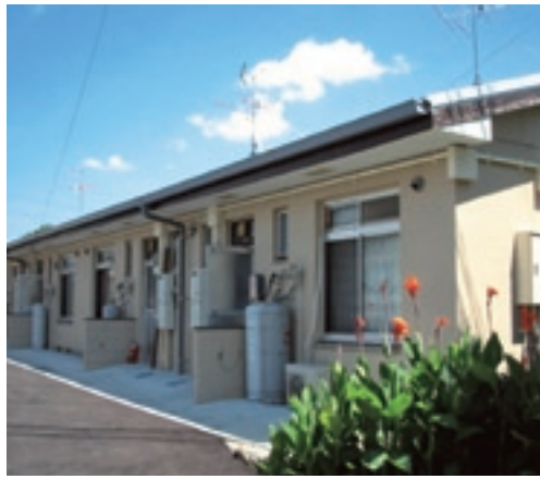
きれいになった改修後の葉山団地
