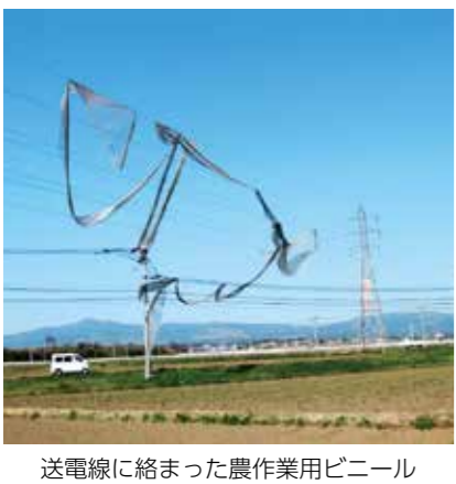
送電線に絡まった農作業用ビニール
