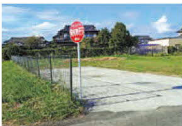
防火水槽の設置
