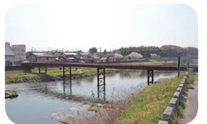
▲合志川橋の仮設歩道橋
