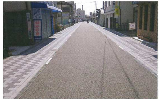
中町小学校線回遊道路整備工事
