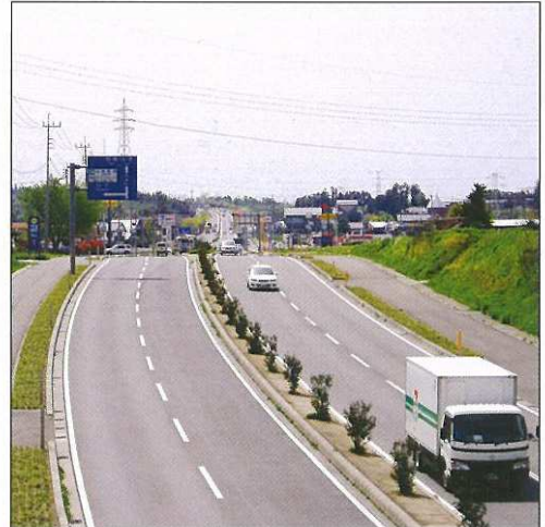
供用後の国道325号(旭志工区)の状況
