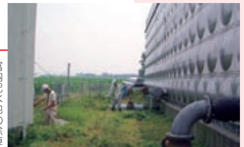
富納配水池の除草作業をする組合員たち
