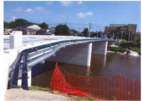
合志川橋橋梁添架工事
