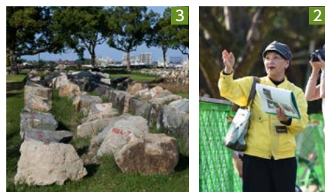
1_ 複数箇所での石垣が損壊(写真は戌亥櫓) 2_ 修復中の熊本城を案内するボランティアガイド 3_ 同じ位置に復元するため整理された崩れた石垣
