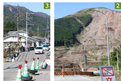
1_ 倒壊した拝殿(阿蘇神社) 2_ 崩落した阿蘇大橋と土砂崩れの跡(南阿蘇村) 3_ 地盤沈下で寸断された道路も現在は通行できる(阿蘇市)
