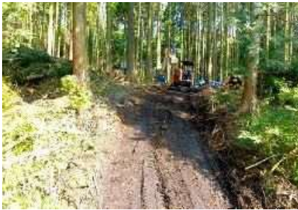
林業のための作業道開設
