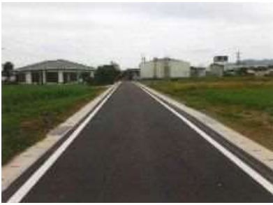
大林寺3号線の道路改良工事
