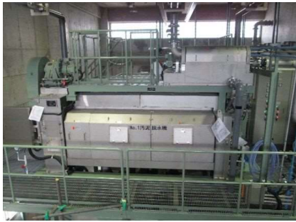
浄水センター改築更新工事(脱水機)
