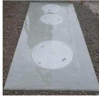
合併浄化槽の新設
