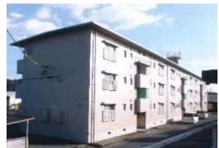
市営住宅(葉山団地)の給水設備工事
