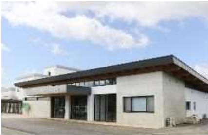
新しく建設された旭志支所
