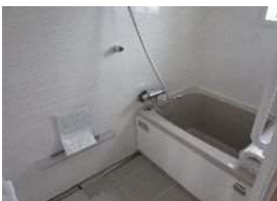
市営住宅(音光寺団地)の浴室工事
