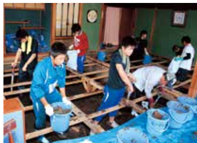
家屋に残る汚泥を撤去するボランティアの皆さん
