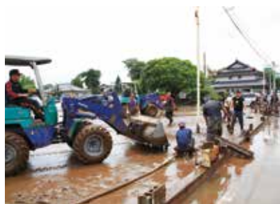
重機械を駆使して汚泥の撤去作業
