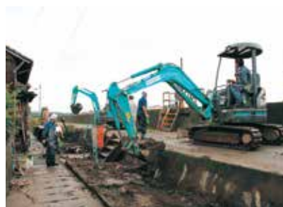
復興作業では消防団やボランティアのほか地元業者の重機械も大活躍した
