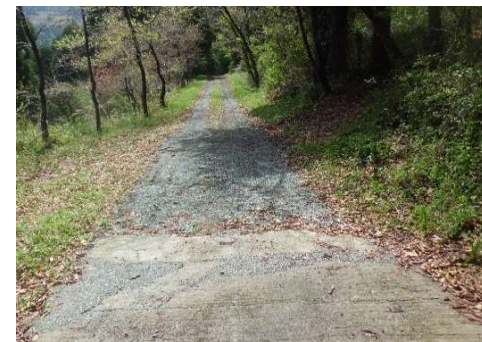
作業道舗装前
