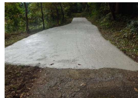
作業道舗装後
