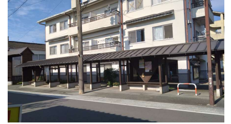
↑御所通に面した箇所にある屋根とベンチ。ウォーカブルの推進のための室内外間わない休憩スペースの創設も重要なファクターとして検討が必要。
