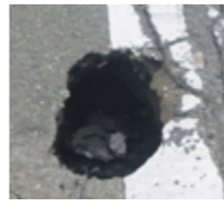
市道の陥没
