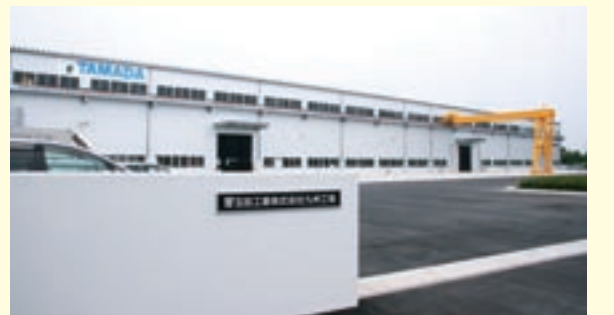
7月に操業を開始した、蘇崎工業団地にある九州工場
