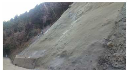
林道八方ヶ岳線法面改良工事状況
