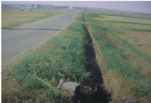
用水路改修前
