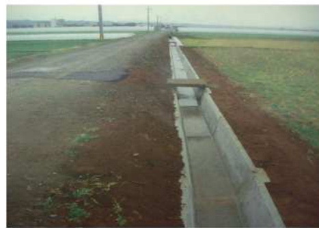
用水路改修後
