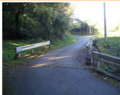
第1戸城橋(補修前)
