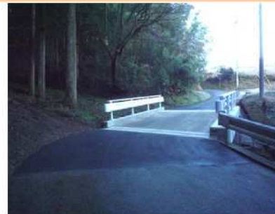
第1戸城橋(補修後)
