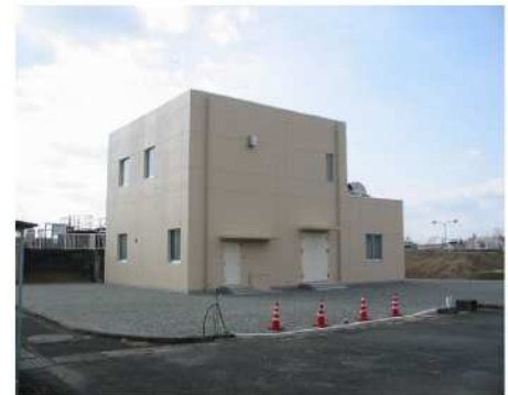
建屋が完成した汚泥機械濃縮施設
