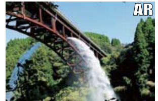
橋の両側から毎秒100%の水を放水
