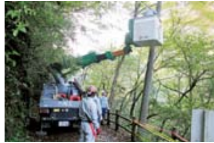
街路灯を点検補修する九電工の社員
