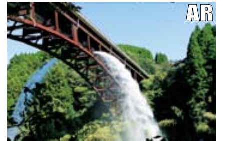
橋の両側から毎秒 100 ㍓の水を放水
