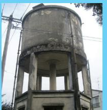
鉄筋コンクリート造、三層構成のラーメン構造。全高13.56m。給水塔の最上部水槽には、1945年5月13日、菊池飛行場の空襲時の機銃弾の跡が抉られた状態で約30箇所確認された。
