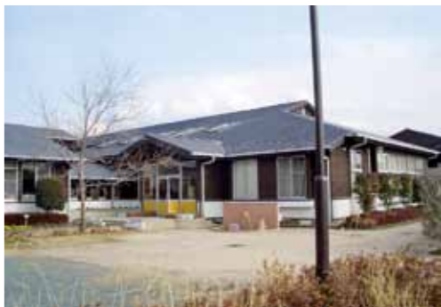
②迫水小学校跡地
