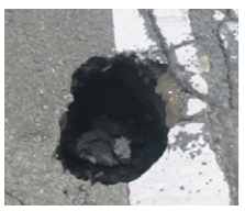
市道の陥没
