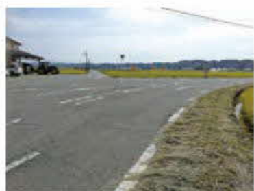
県道旭志鹿本線(新古閑地内)より、国道387号方面を望む
