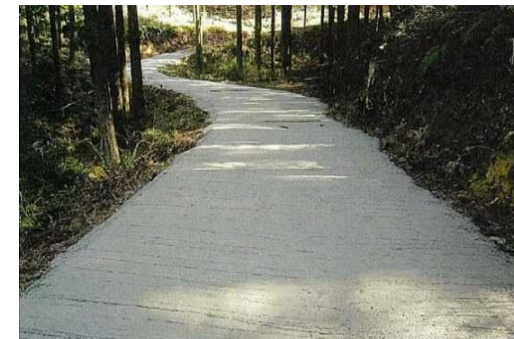
作業道舗装後
