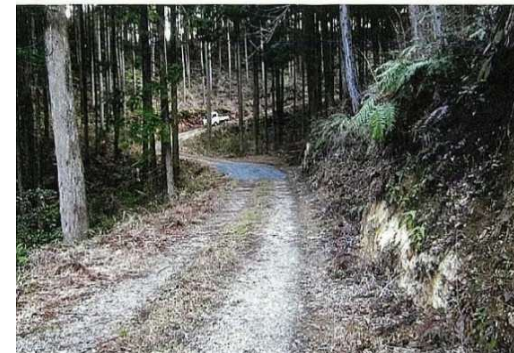
作業道舗装前
