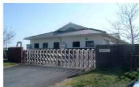
七城北部浄化センター
