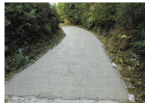
作業道舗装後
