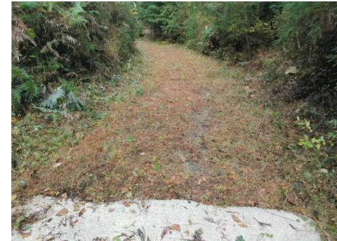
作業道舗装前
