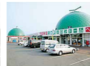
道の駅七城メロンドーム
