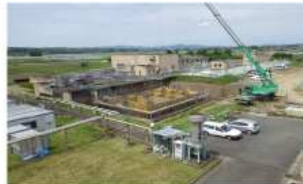
浄水場改築更新工事
