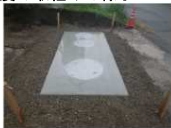
浄化槽設置工事
