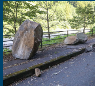
【市道古川伊倉線】巨大な落石により、全面通行止め。この他、市道鳳来兵戸線が道路崩壊により、全面通行止め(8月21日現在)
