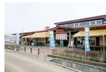
道の駅泗水養生市場
