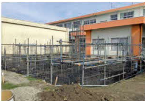
増築等の工事が進む菊池小学校
