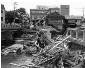
※泗水ふれあい橋の崩壊（平成24年時）
