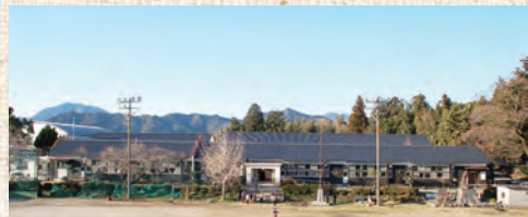
きくちふるさと水源交流館
