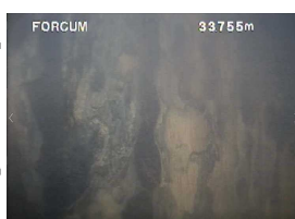
9. ケーシング 管頭-33.75m 井壁に黒い部分が多く見られる。ブラッシングにより、鉄こぶやスケールが剥落した痕と思われる。
