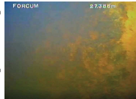
7. ケーシング 管頭-27.38m 井内水位面以深よりケーシングの褐色の錆こぶが大きくなる。
