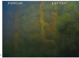
11. スクリーン? 管頭-36.11m この付近より、等間隔の縦方向の隆起が連続しており、スクリーンの縦スリットのように見える。
