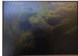
13. スクリーン? 管頭-46.87m 大きいこぶ状の突起が見られる。
