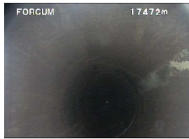
3. ケーシング(水上) 管頭-17.47m 水上のケーシング。スケールや破損はなく健全である。褐色の錆がブラッシングにより落ちている。
