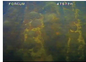
15. スクリーン? 管頭-47.55m 47.55m付近でカメラが入らなくなった。井壁には礫のようなものが多く確認される。
