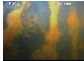
11. スクリーン? 管頭-36.11m この付近より、等間隔の縦方向の隆起が連続しており、スクリーンの縦スリットのように見える。
