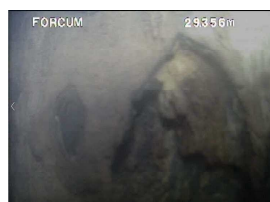
7. ケーシング 管頭-28.69m ケーシング継目と見られる。更生前の褐色の鉄こぶ状の突起やケーシングの破損は見られない。
