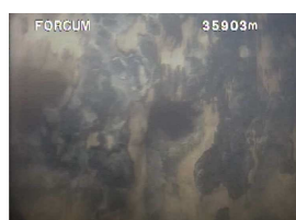
9. ケーシング 管頭-33.75m 井壁に黒い部分が多く見られる。ブラッシングにより、鉄こぶやスケールが剥落した痕と思われる。
