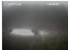
3. ケーシング(水上) 管頭-17.47m 水上のケーシング。スケールや破損はなく健全である。褐色の錆がブラッシングにより落ちている。
