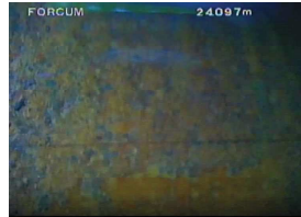
3. ケーシング(水上) 管頭-12.31m 付近に継目があるのが確認できる。大きなスケールや破損はなく健全である。
