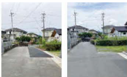
北宮1号線の狭窄区間 (整備後)
