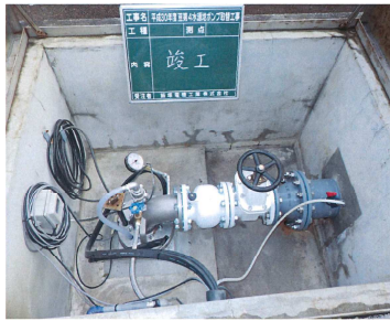
水源地ポンプ取替工事
