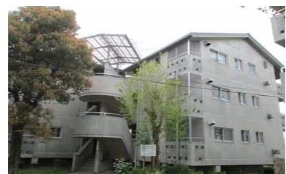
朝日西団地の改修工事
