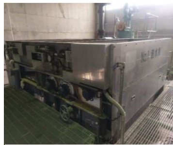
下水処理施設改築更新事業
