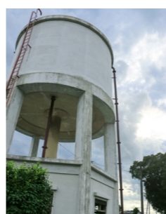
花房飛行場給水塔(市指定文化財)
