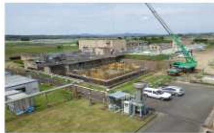
浄水場改築更新工事
