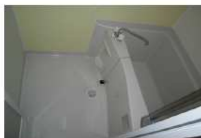
葉山団地内装リフォーム
