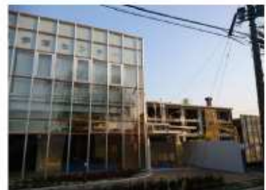
生涯学習センター建設
