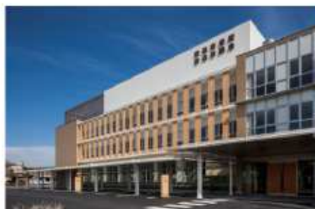
庁舎増築棟の完成
