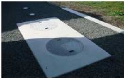
浄化槽設置工事
