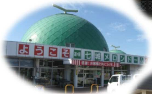
道の駅七城メロンドーム
