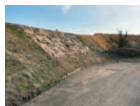
小災害復旧後
