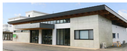
【旭志支所】同敷地内に新庁舎を縮小し建て替え。旧庁舎は解体
