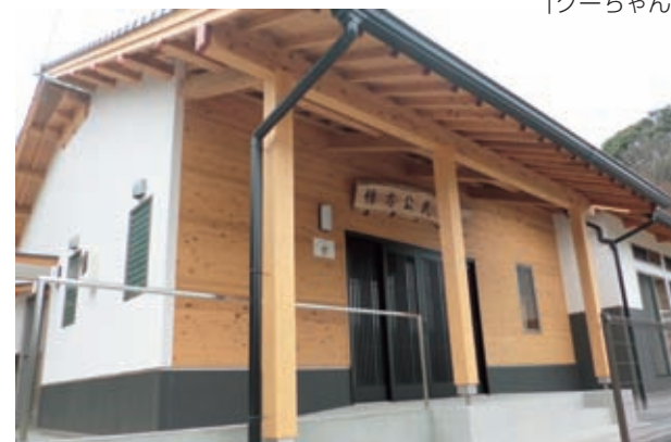
コミュニティ助成事業で建設された稗方公民館
