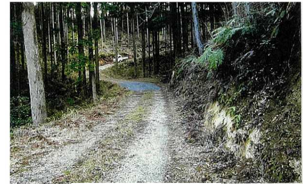
(作業道舗装前)
