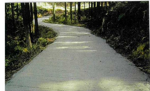
(作業道舗装後)
