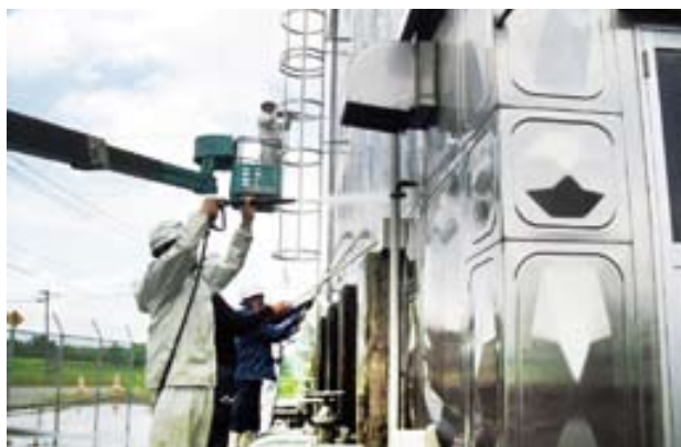
配水タンクを清掃する組合員の皆さん
