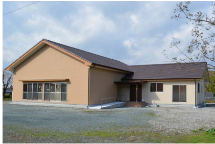
高野瀬区コミュニティセンター（公民館）
